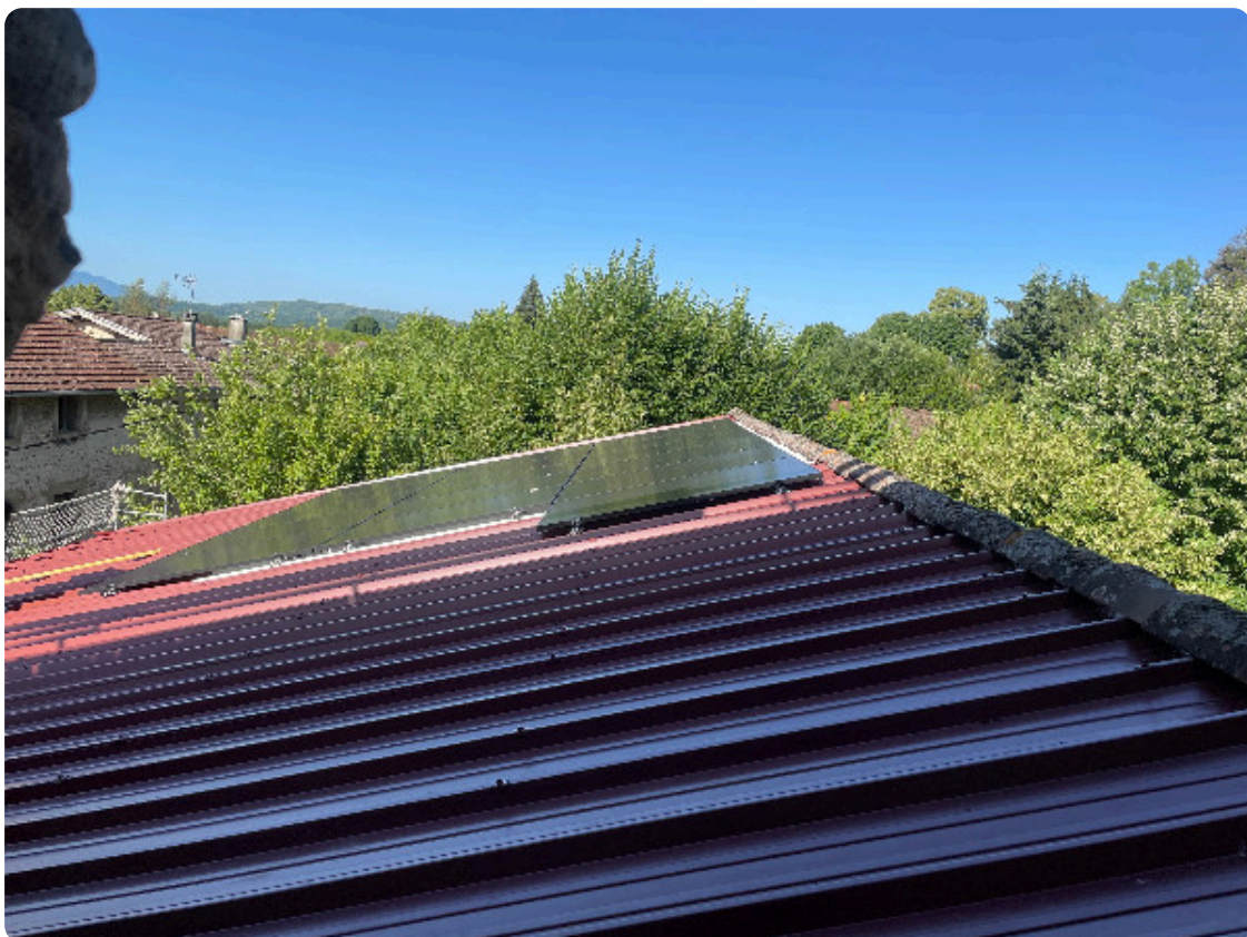
Chantier à Vinay, chez M. et Mme Blunat
